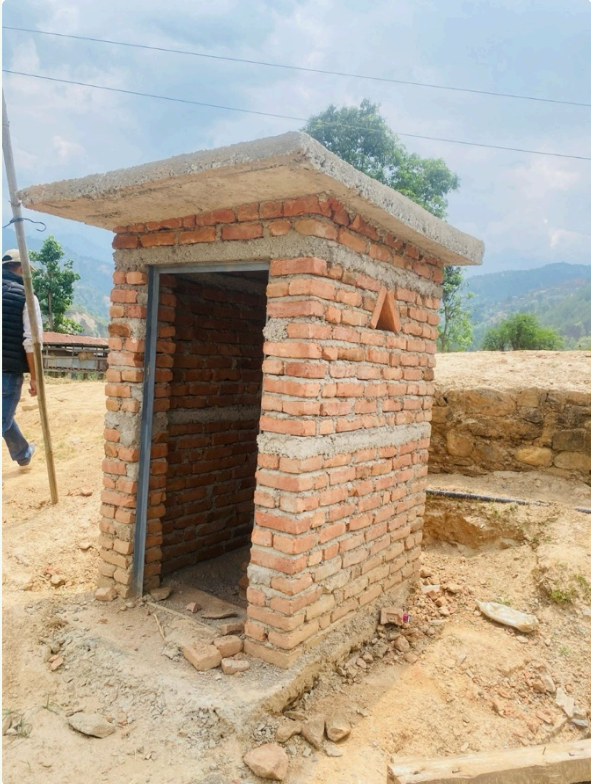
Neues Toilettenhäuschen im Bau: Geplant sind 23 Toiletten in Samantar (Thakre Rural Municipality). Ein Wassertank wird auf dem Dach angebracht, das Brauchwasser wird in einem Tank unter der Toilette aufgefangen (Mai 2025)
